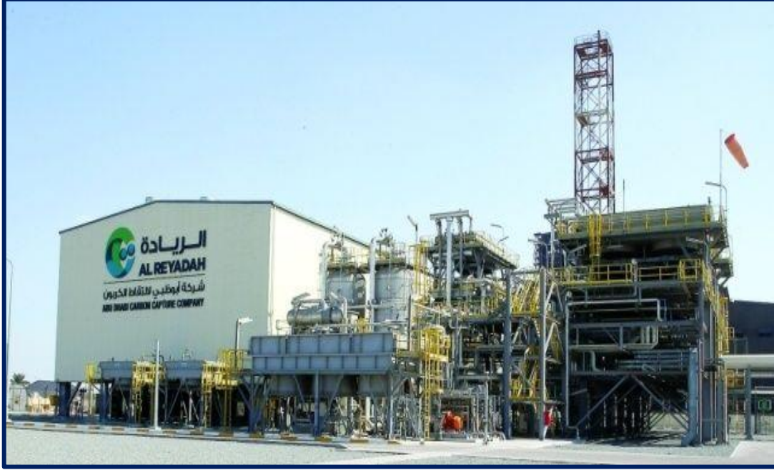
الشكل (28): وحدة احتجاز غاز ثاني أكسيد الكربون في مشروع " الريادة "
